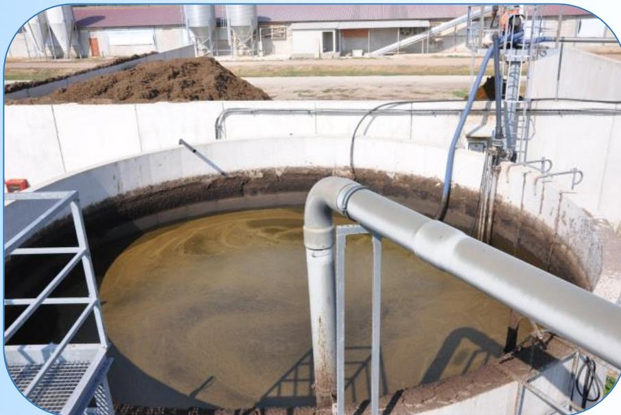
E' un materiale che risulta più omogeneo rispetto alle matrici di partenza con un maggiore tenore di umidità in quanto parte della sostanza secca è stata degradata biologicamente dai batteri per la produzione del biogas. La sostanza organica residua risulta più stabile e contiene elementi della fertilità del suolo per le colture.
